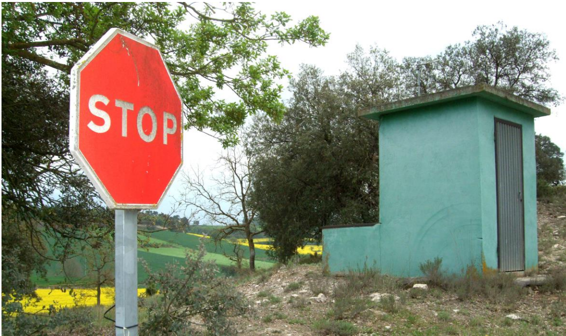
3 Pou d'aigua potable del nucli d'Alta-riba, a tant sols 10 metres de la pedrera
